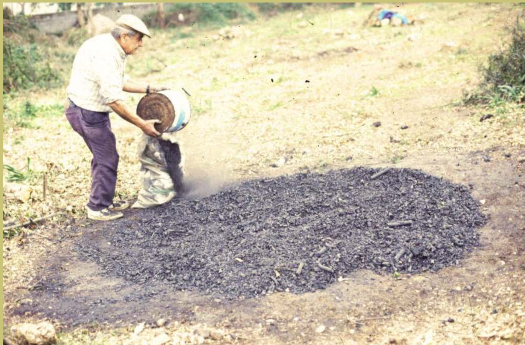
Un hombre trabajando en la construcción de un horno de carbón
